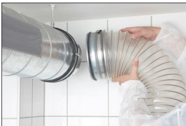
Fig. 21: Collegamento del tubo spiralato all'impianto da pulire
