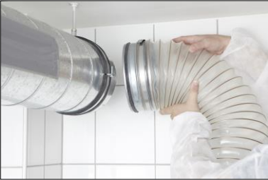
Image 9: Connecter le tuyau au tube à nettoyer
